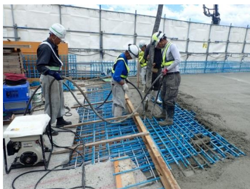
現場打ち床版の施工状況
