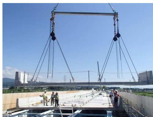
プレキャスト床版の施工状況
