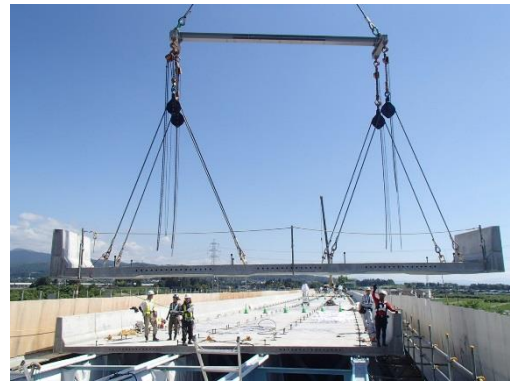
新しい床版の設置
