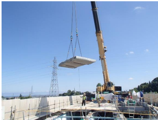
老朽化した床版の撤去
