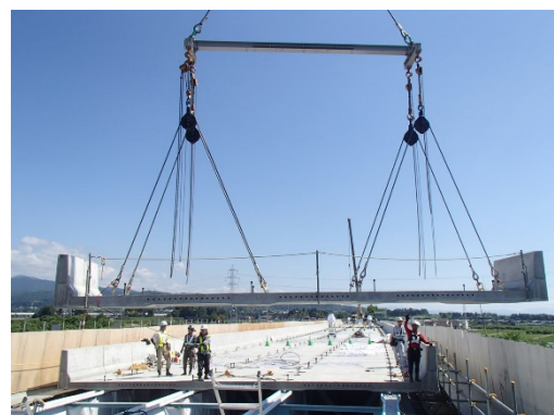
新しい床版の設置
