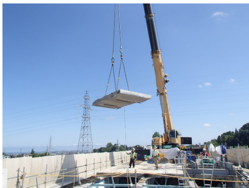
老朽化した床版の撤去
