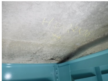
九頭竜川橋の床版下面
