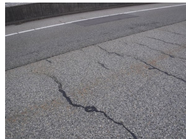
九頭竜川橋の路面
