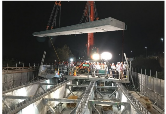
プレキャスト床版の施工状況
