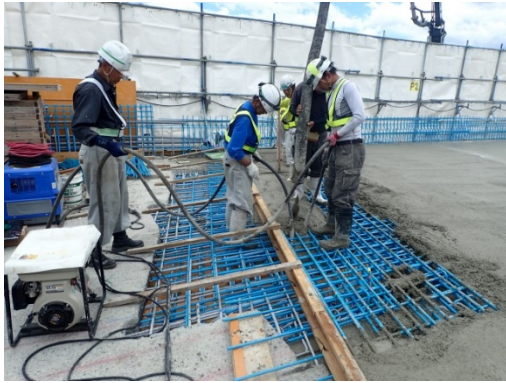
現場打ち床版の施工状況
