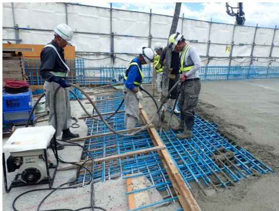
【現場打ち床版の施工状況】
