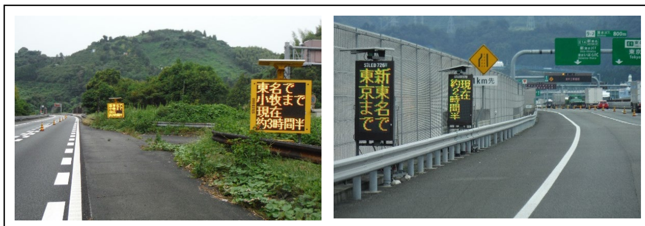
【迂回ルートへの分岐部手前の仮設情報板の所要時間表示イメージ（昨年度設置状況）】
