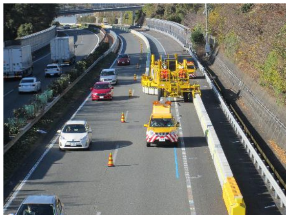
（コンクリート防護柵設置状況の例）
