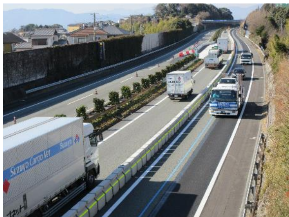
（コンクリート防護柵設置状況の例）
