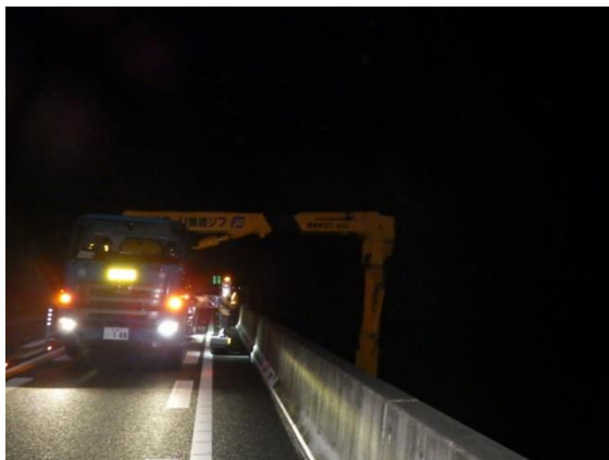
(橋梁点検車を用いた橋梁下面及び橋桁の点検)
