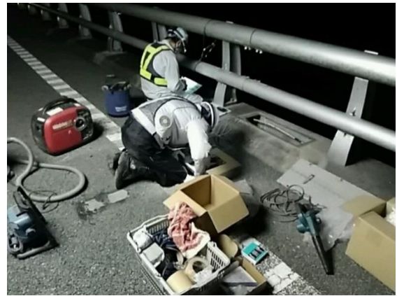
(排水装置、伸縮装置などの点検)
