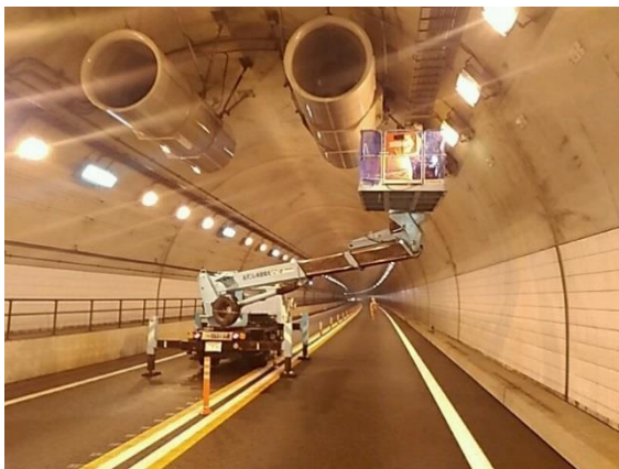
(トンネル換気設備点検)
