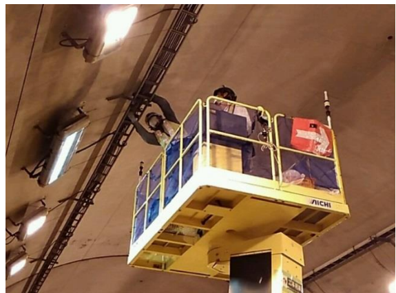
(トンネル照明設備点検)
