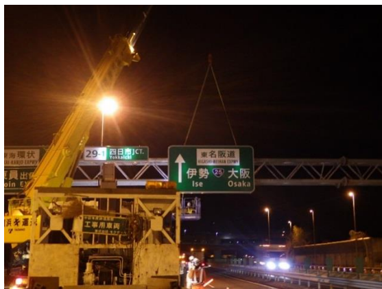
(標識のナンバリング工事)
