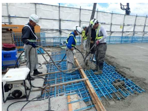
現場打ち床版の施工状況
