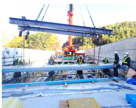
プレキャスト床版の施工状況
