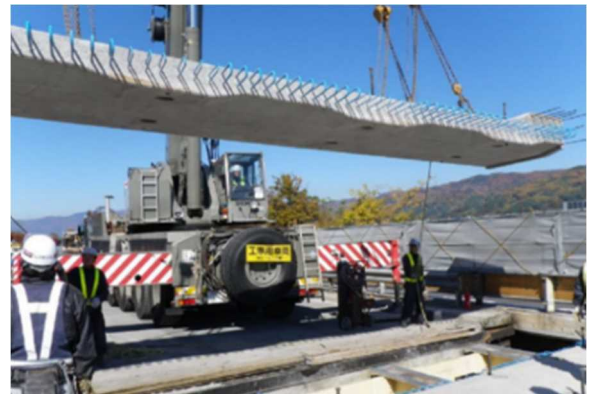
新しい床版の設置
