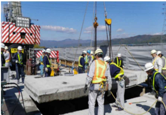
老朽化した床版の撤去
