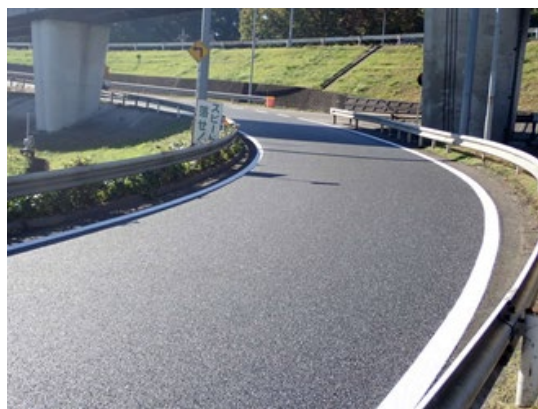
<ランプ舗装補修工事>
