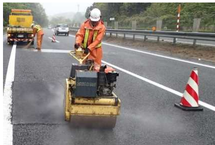
《 路面損傷箇所の補修例 》
