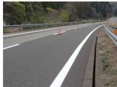
《 路面標示工の施工例 》
