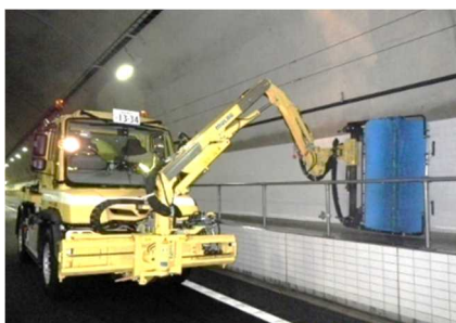
《 トンネル側壁清掃 》
