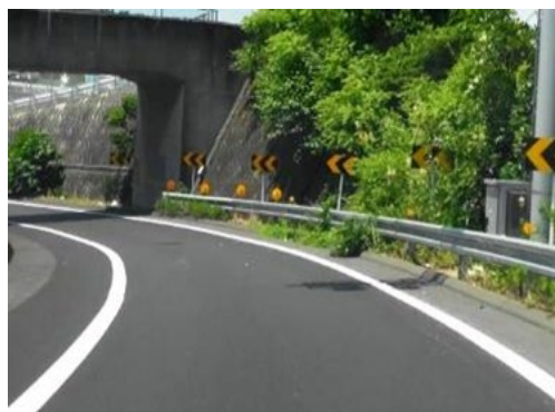
<ランプ舗装補修工事>
