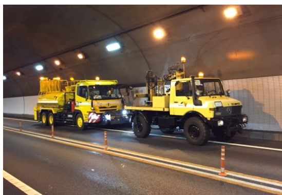
(トンネル壁面清掃)
