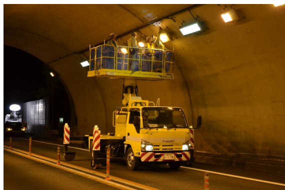
(トンネル照明点検)
