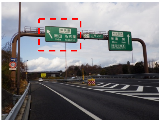
(取替対象の標識)
