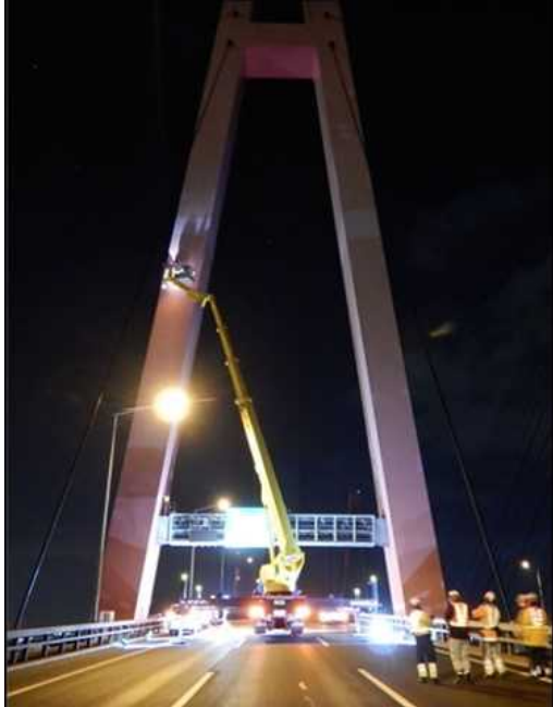
(高所作業車での点検)
