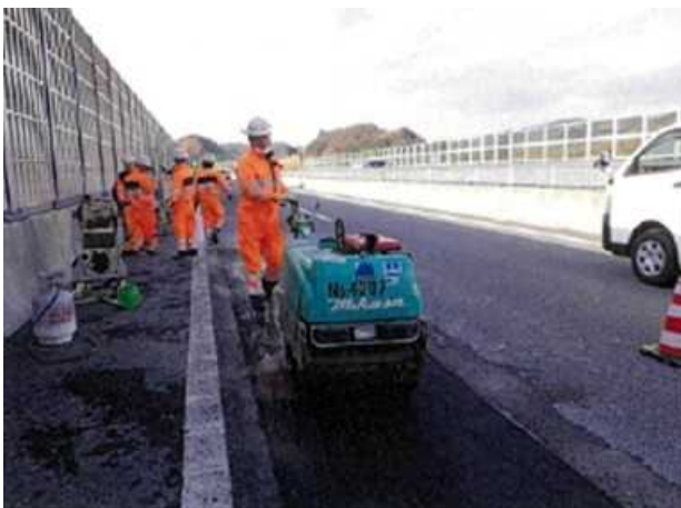
(舗装補修工事)
