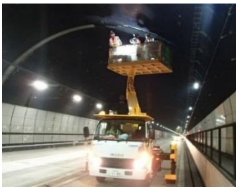
《トンネル点検》
