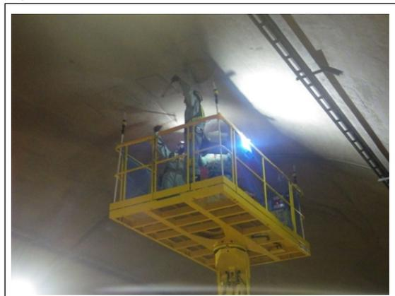
(高所作業車を用いたトンネル点検)
