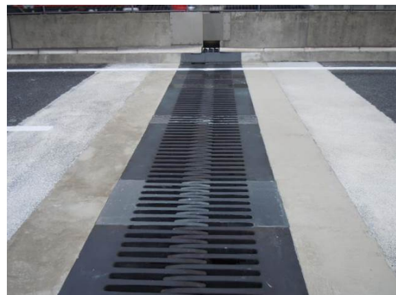
④ 工事完了
