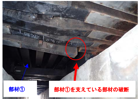
橋梁下面からの伸縮装置損傷状況
