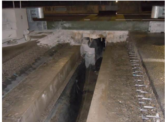
② 伸縮装置の撤去後の状況
