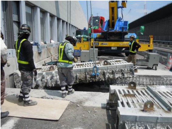
① 損傷した伸縮装置を撤去
