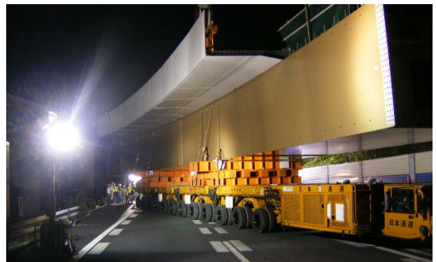
《多軸式特殊台車による架設工事の施工例》
