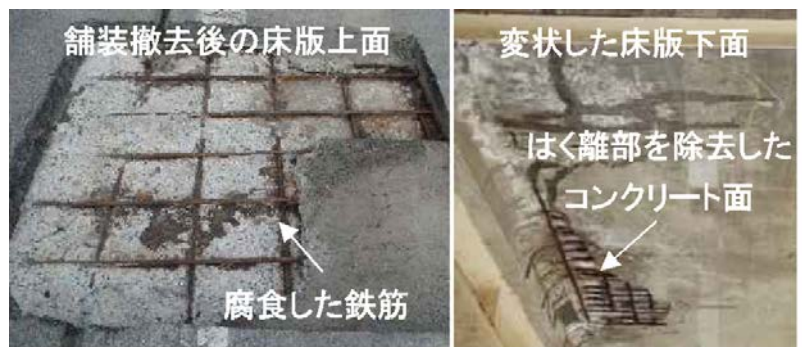
【写真7】橋梁の鉄筋コンクリート床版の塩害劣化事例（※2）
