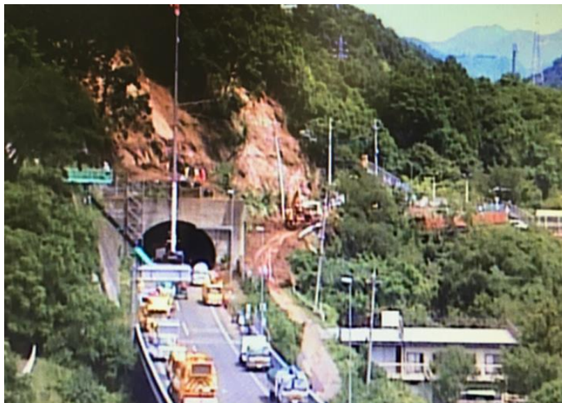
【写真2】応急復旧状況 8月9日 14時撮影
