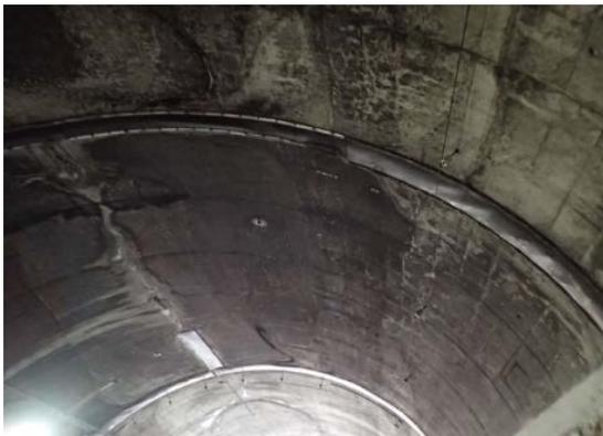
辰野トンネル 覆工コンクリートの劣化状況
