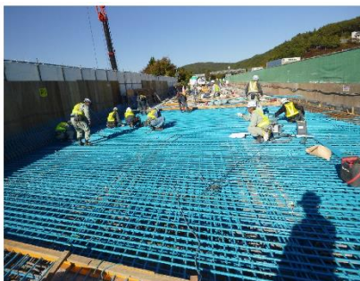
鉄筋・型枠組立状況
