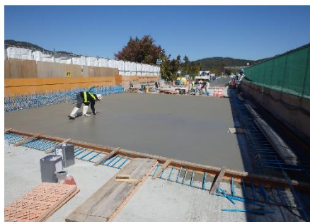
コンクリート打設状況
