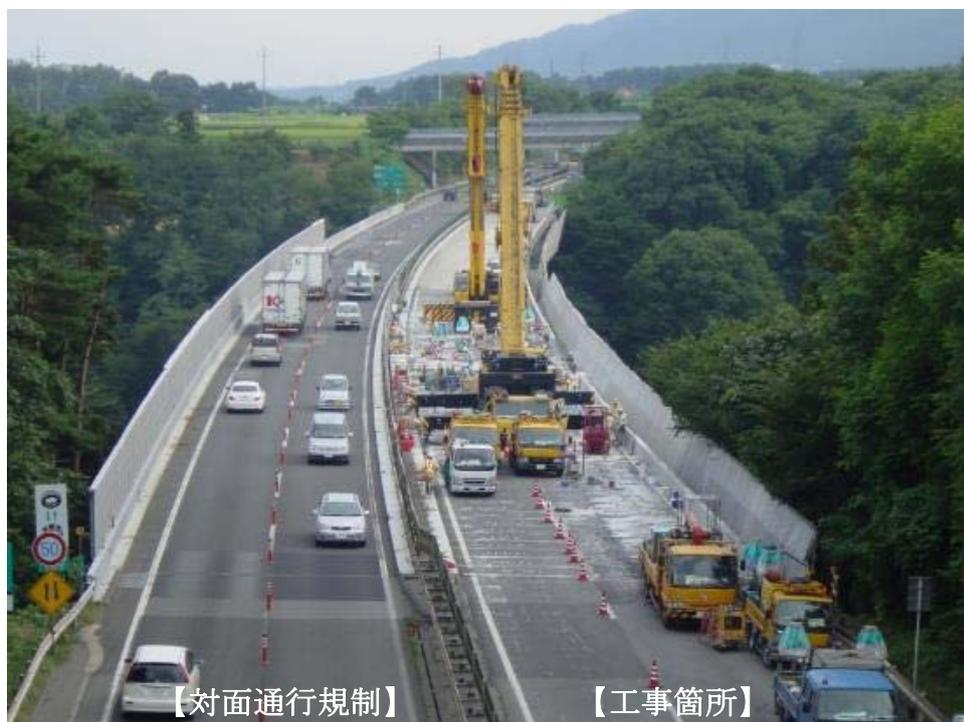
小沢川橋の床版取替工事では大型クレーン車を工事箇所に配置し、工事を行いました。
