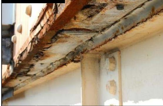
張出部では舗装のひび割れから染み込んだ雨水や凍結防止剤により、コンクリート床版内の鉄筋が錆び、膨張することにより、コンクリートに浮き・はく離が発生。
