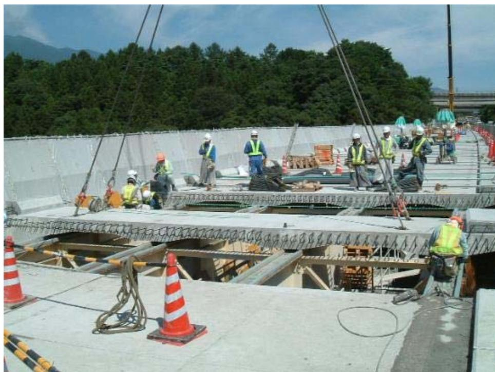
老朽化した鉄筋コンクリート床版の撤去や新しい床版（プレキャストコンクリート床版）の設置は、大型のクレーンを使用して行いました。
