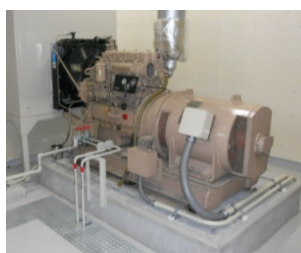
実際に使用していた自家発電設備
