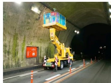
＜トンネル内設備の点検作業状況＞
