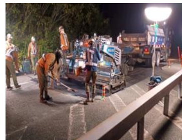
＜舗装の補修状況＞
