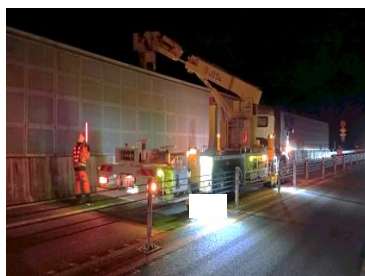
＜橋梁の点検状況＞
