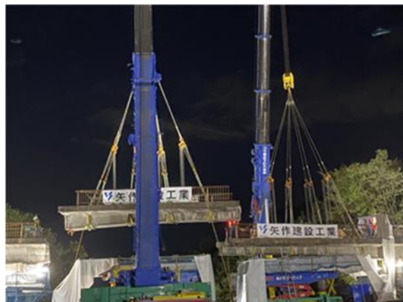
【大型クレーンによる撤去作業】
