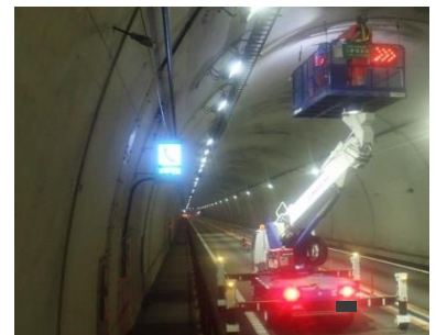
トンネル内の点検
