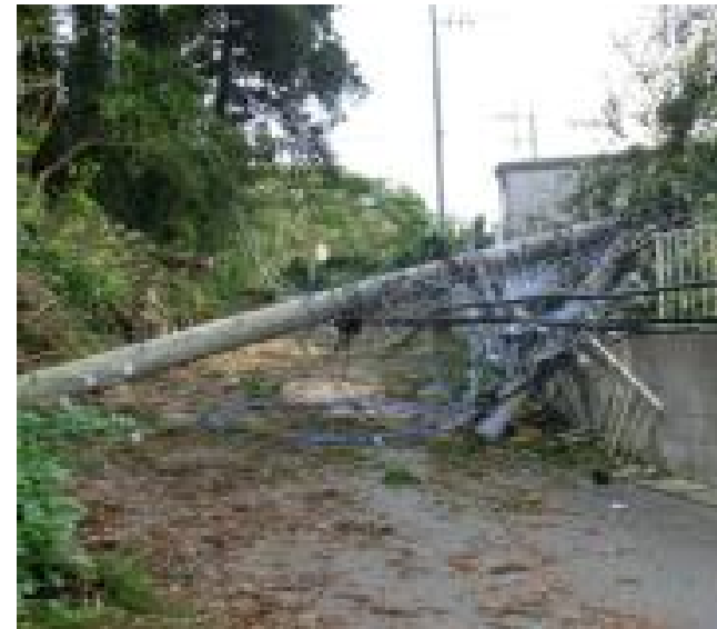
令和元年9月 千葉県山武市 山武市道
