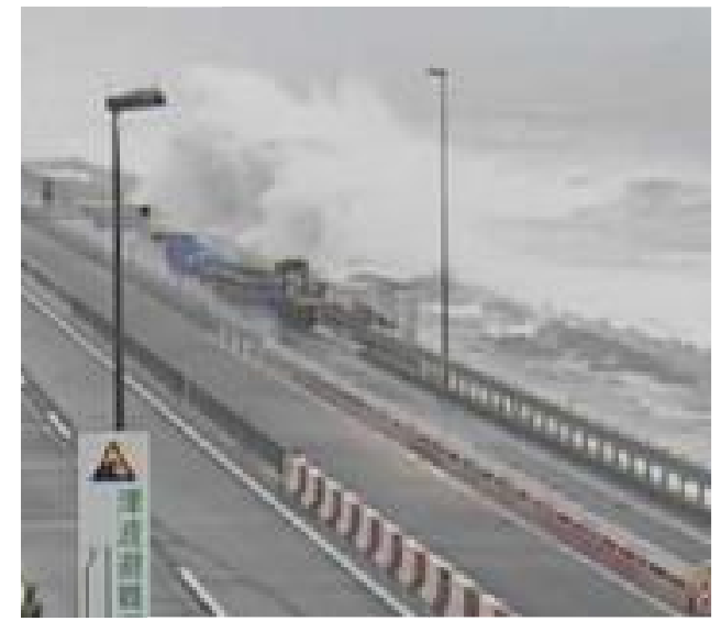
令和元年9月 神奈川県大磯町 国道1号
