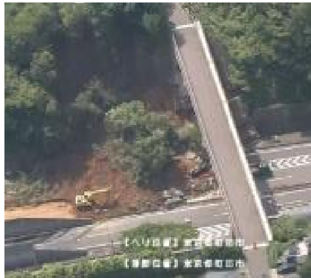
令和5年6月 東京都町田市 国道16号
