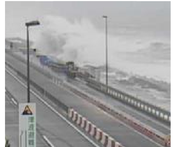
令和元年9月 神奈川県大磯町 国道1号
