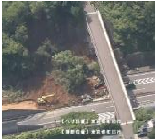
令和5年6月 東京都町田市 国道16号
