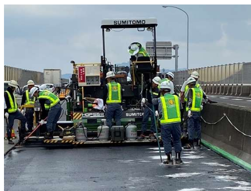
床版防水の施工
