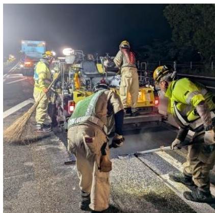
舗装補修工事(イメージ)
