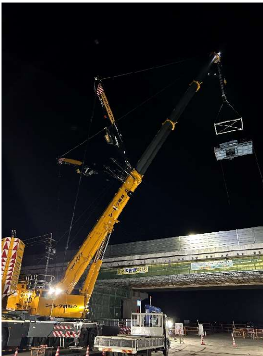
床版架設機の撤去作業状況(左:高架下から撮影、右:道路上で撮影)
