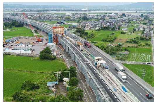
過年度の東名阪道リニューアル工事の状況
