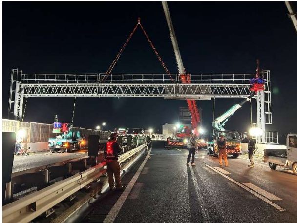
門型標識の撤去作業状況
