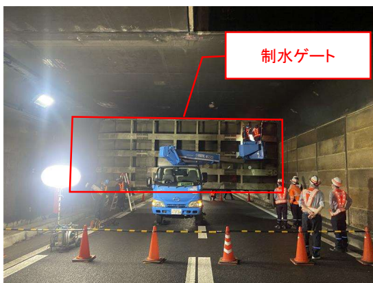
制水ゲートの点検
