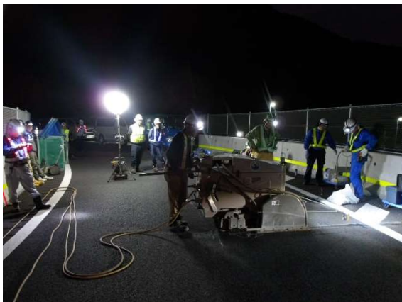
【施工状況①】
