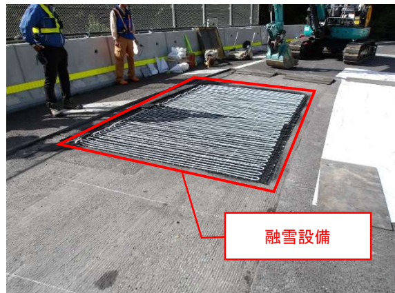
【施工状況②】
