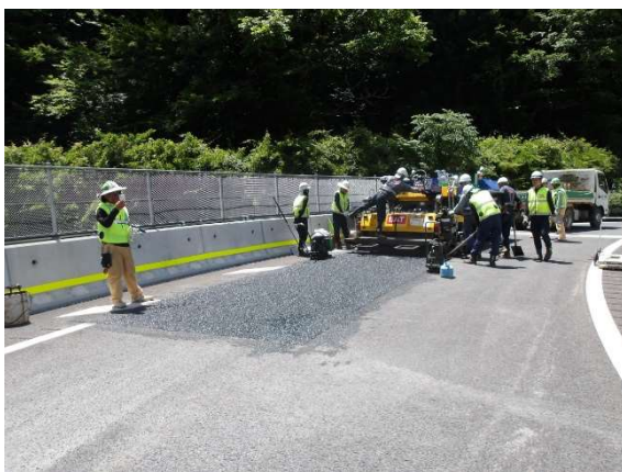
【施工状況③】
