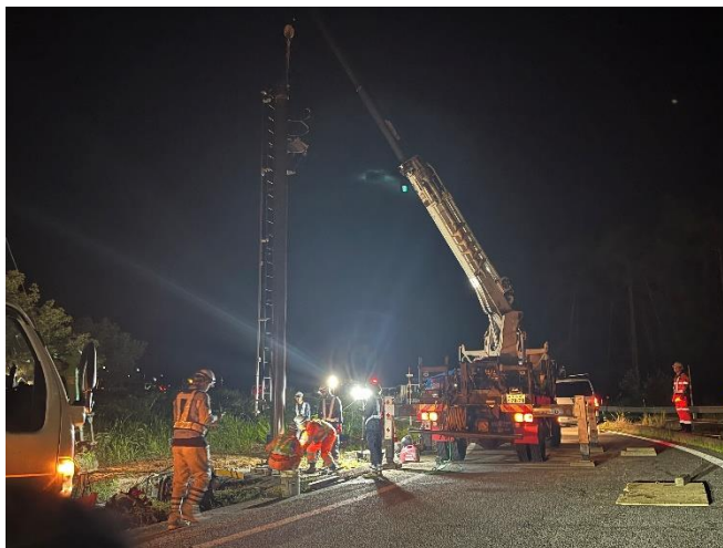
CCTV カメラ設置工事
