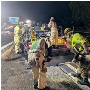
舗装補修工事(イメージ)
