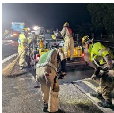
舗装補修工事(イメージ)
