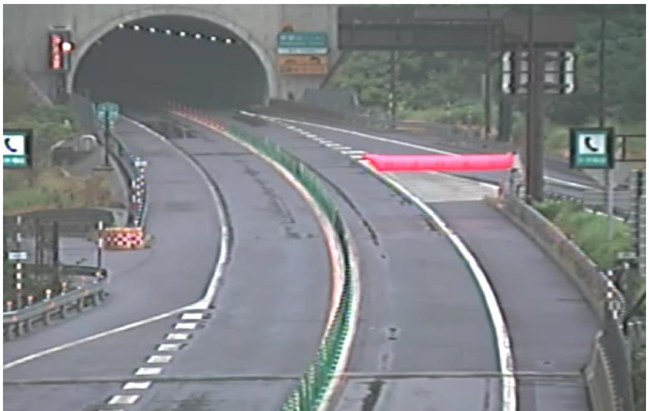
簡易規制装置(エア一遮断機)
