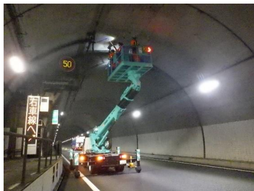
トンネルの点検
