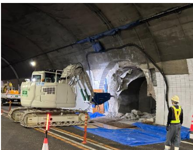
4車線化工事 (トンネル避難連絡坑拡幅)
