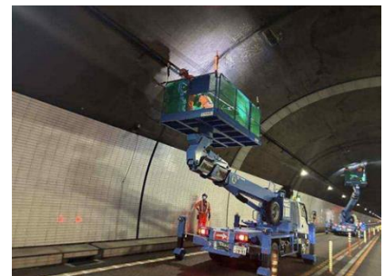
トンネル内の点検
