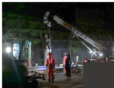
CCTVカメラ設置工事
