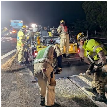
舗装補修工事(イメージ)
