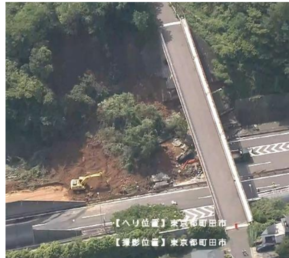
令和5年6月 東京都町田市 国道16号
