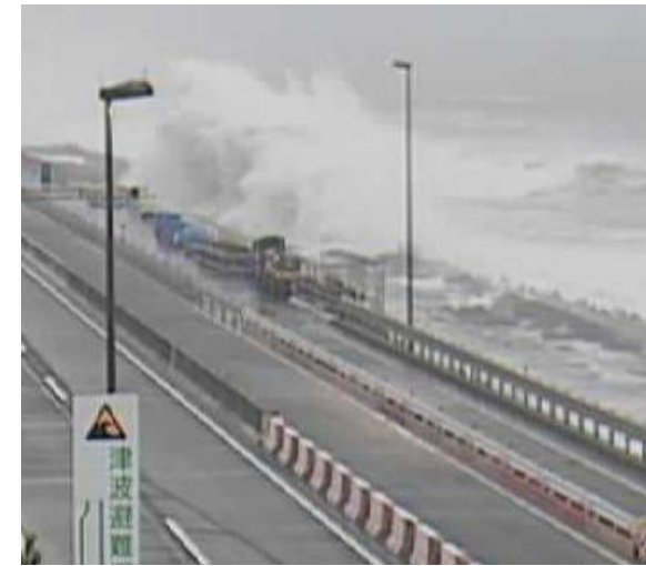
令和元年9月 神奈川県大磯町 国道1号
