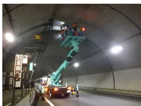
トンネルの点検
