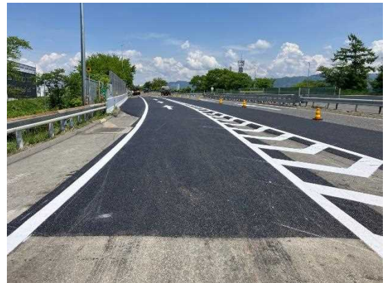
【入口側 施工後】
