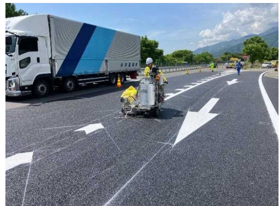
【入口側 施工状況】
