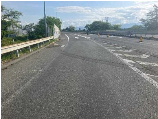
【入口側 施工前】
