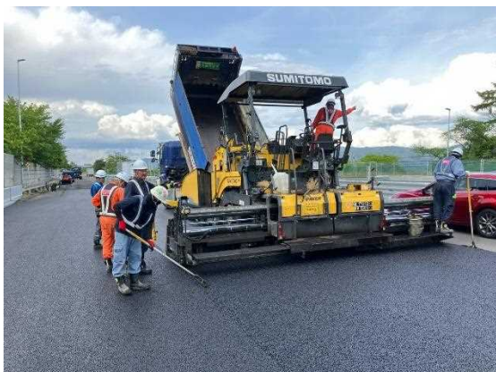
【入口側 施工状況】
