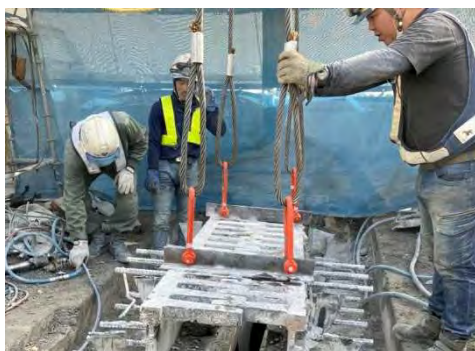
既存の橋梁伸縮装置を撤去
