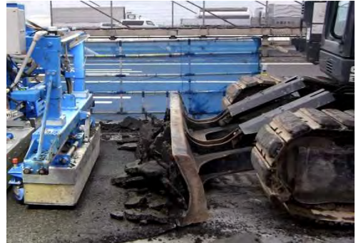
既設舗装の撤去
