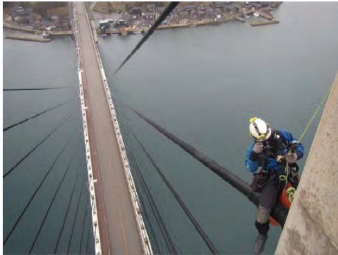
ロープ高所作業の例①
