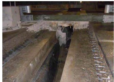
橋梁伸縮装置の撤去後の状況
