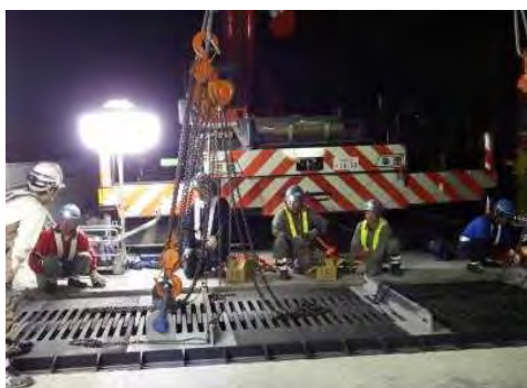
新しい橋梁伸縮装置を設置
