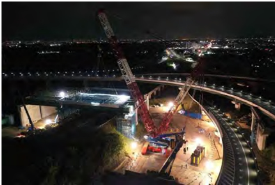
橋梁の桁架設状況
