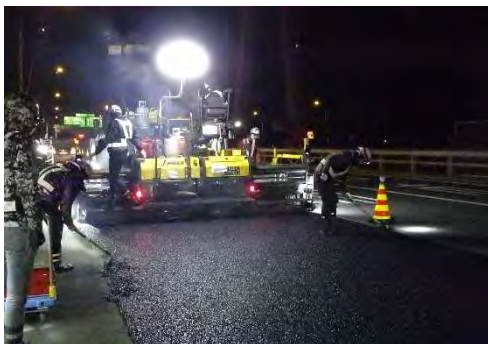
新しい舗装の舗設
