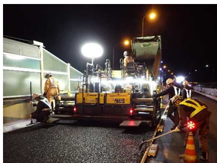
アスファルトの舗設状況
