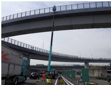
道路構造物の点検状況
