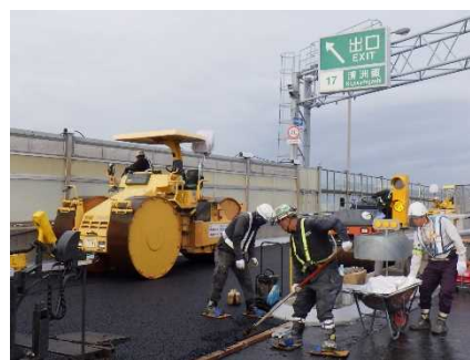
舗装の転圧等状況
