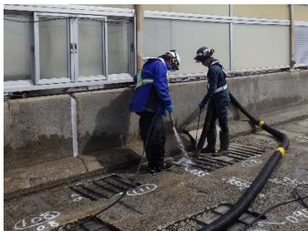
床版の損傷部分の除去
