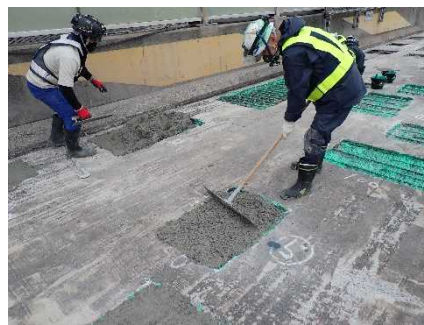
床版の補修状況
