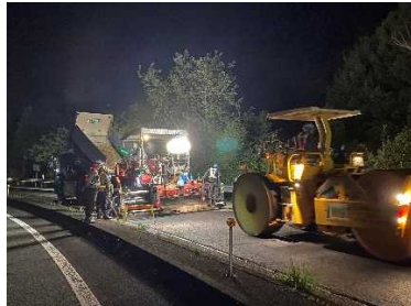
<舗装の補修状況>
