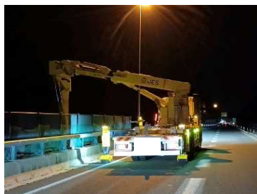
<橋梁の点検状況>
