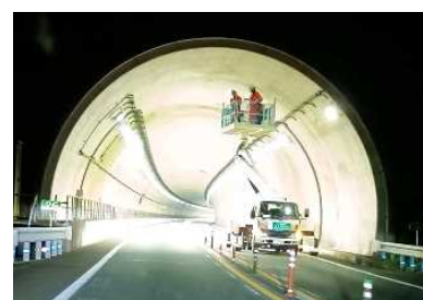
<トンネル内設備の補修作業状況>
