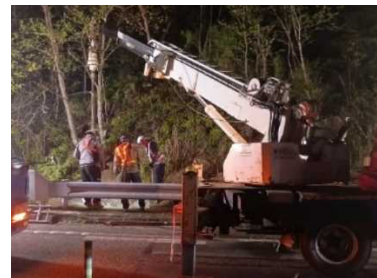
<CCTV カメラ設置状況>
