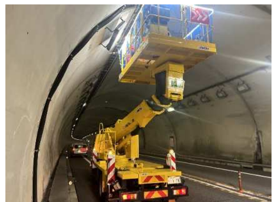
<トンネル内設備点検状況>
