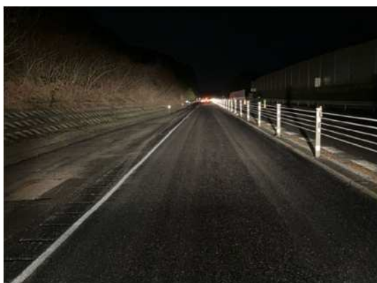
<舗装補修工事(施工後)>
