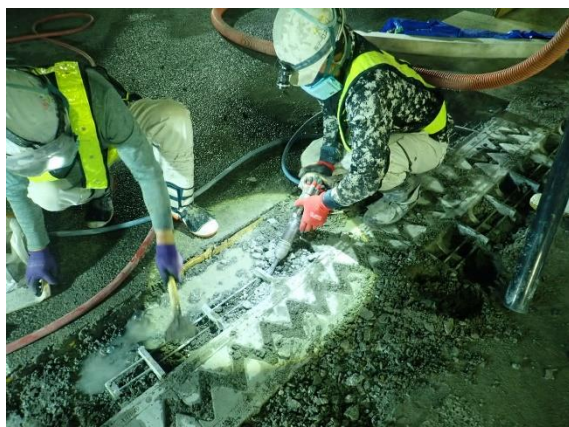
路面補修工事(イメージ)
