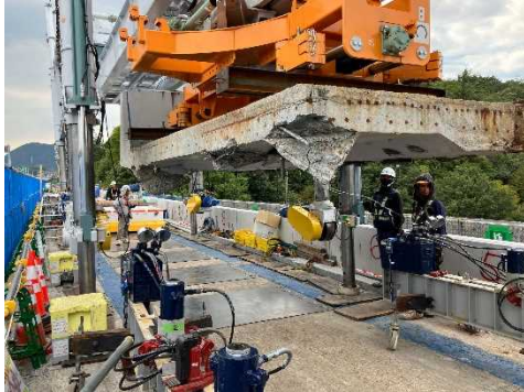
コンクリート床版の撤去(イメージ)
