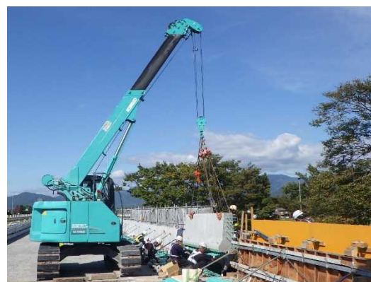
新しい防護柵の設置
